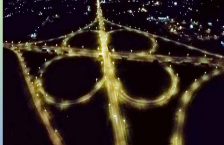
ILUMINACIÓN VÍAL Y DE TÚNELES
